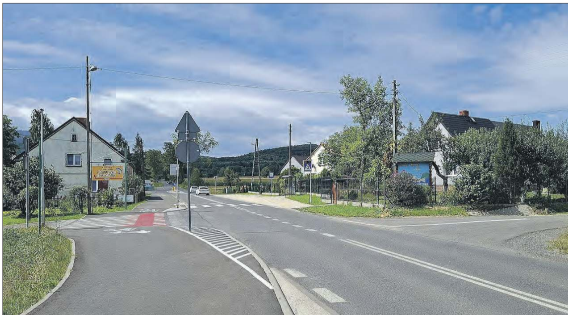
Zmodernizowana droga powiatowa w Moszczance
