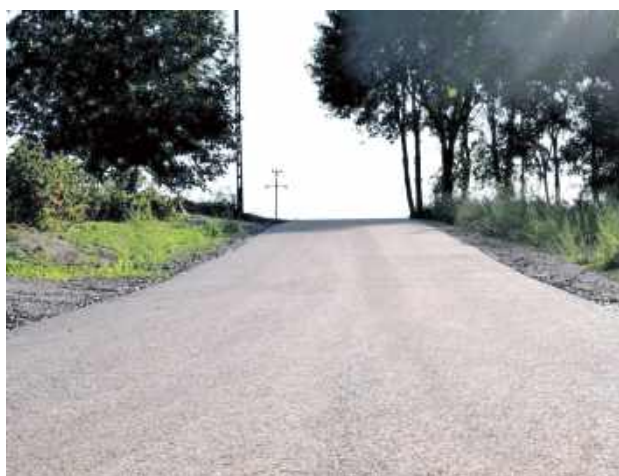
Nowa droga w Teodorówce umożliwi dojazd do budynków mieszkalnych
