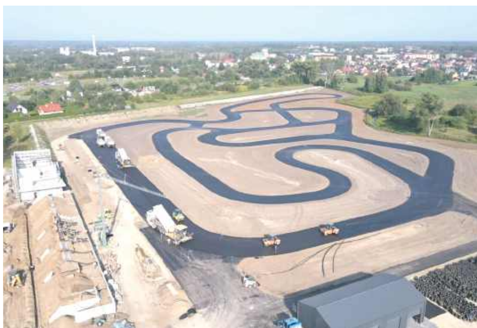
Budowa Autodromu w Biłgoraju wkracza w decydującą fazę
