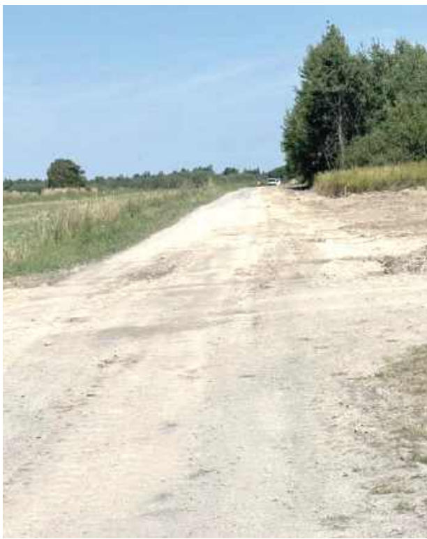
Na terenie przy dawnym SKR w Aleksandrowie Pierwszym, prace idą pełną parą. A tu wkrótce nowa droga
