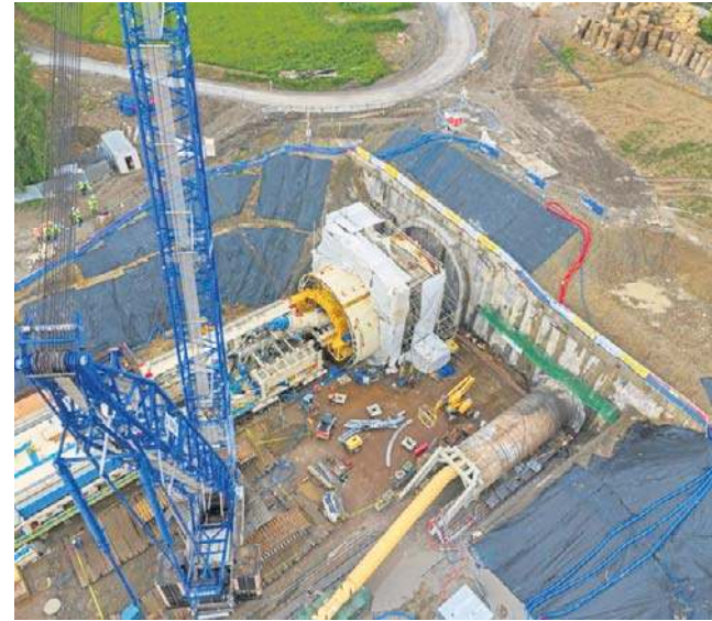
Tak wygląda plac budowy na tym fragmencie linii kolejowej Podłęża - Piekiełko
