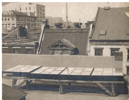
Fotografia 5. Pierwszy na świecie panel słoneczny na dachu, zainstalowano w 1884 r. w Nowym Jorku. Wykorzystano selenowe ogniwa Frittsa. Źródło: https://en.wikipedia.org/wiki/Charles_Fritts#cite_note-1 https://cleantechnica.com/2014/12/31/photovoltaic-dreaming-first-attempts-commercializing-pv/
