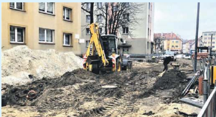
W ramach rewitalizacji prowadzone są prace budowlane w Rynku oraz na ul. Wrocławskiej
