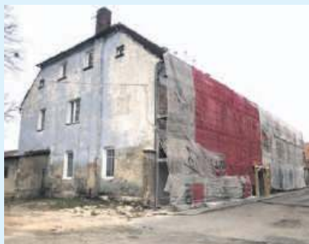
Remont budynku mieszkalnego przy ul. Kutrowskiego 4
