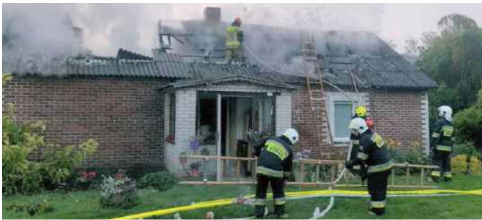
Strażacy musieli rozebrać dach budynku
