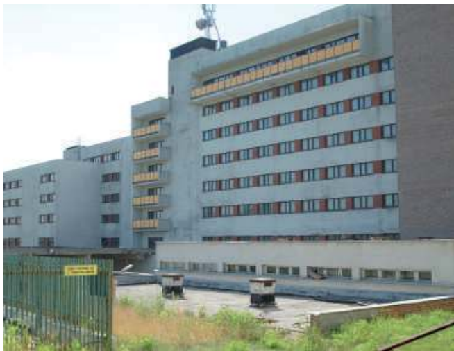
Potężny kilkukondygnacyjny gmach, który miał być chlubą ówczesnych władz. Niestety budowa nigdy nie została ukończona
