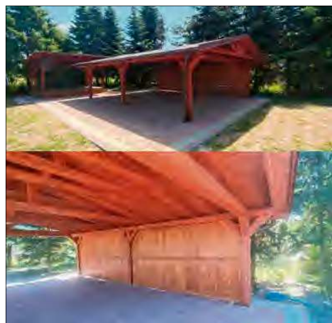
Z kolei w Łędzinach zakres robót objął ułożenie kostki brukowej pod altanę oraz zadeskowanie jej ściany.
