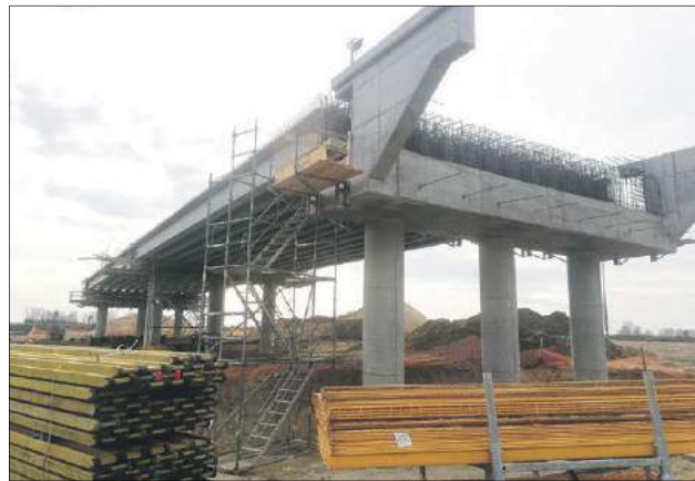
Powstały już pierwsze konstrukcje na odcinku autostrady A2 Swory – Biała Podlaska
