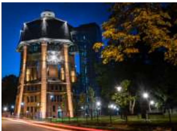
► Zrewitalizowana wieża ciśnieni przy ul. Zamoyskiego Fot. UM Zabrze
