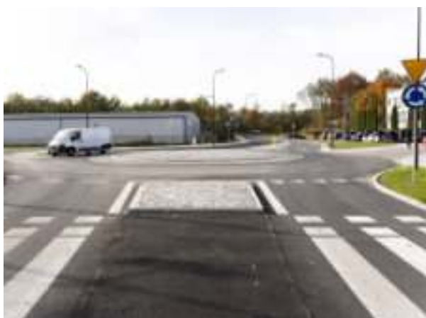
► Rozbudowa układu komunikacyjnego miasta Fot. UM Zabrze
