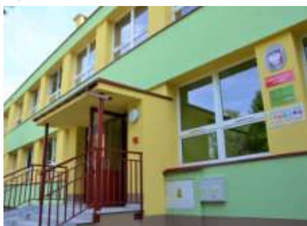
► Termomodernizacja kolejnych szkół i przedszkoli Fot. UM Zabrze
