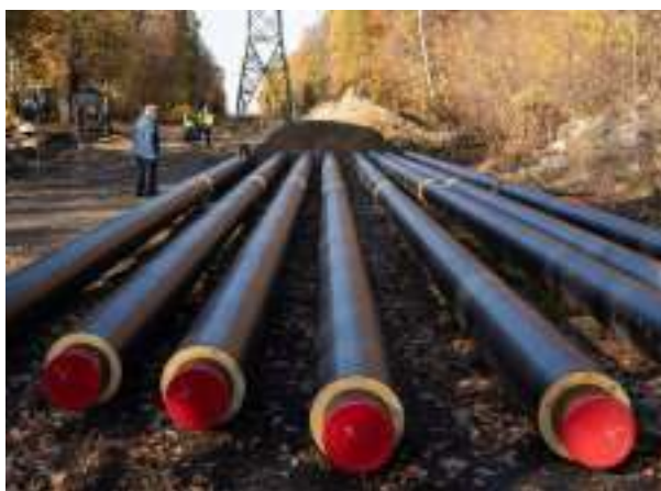
► Budowa sieci ciepłowniczej w Rokitnicy i Helence Fot. UM Zabrze
