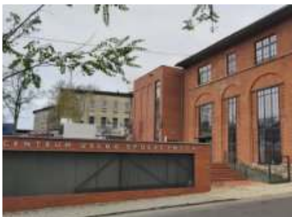
► Centrum Usług Społecznych w budynku dawnej gazowni Fot. UM Zabrze
