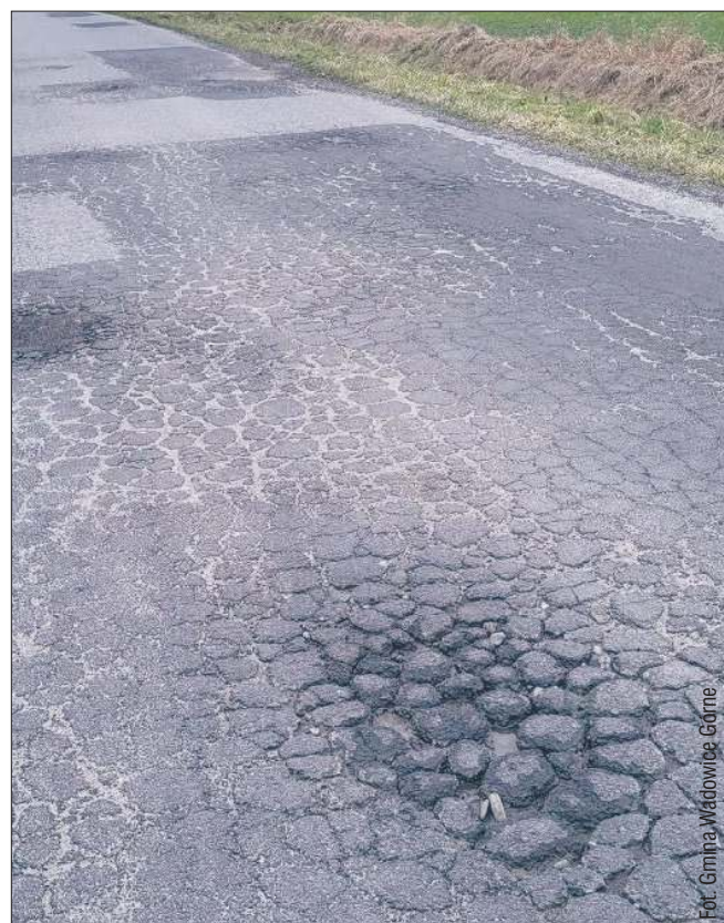
Droga Wierzchowiny-Wola Wadowska-Jamy zostanie zmodernizowana.
