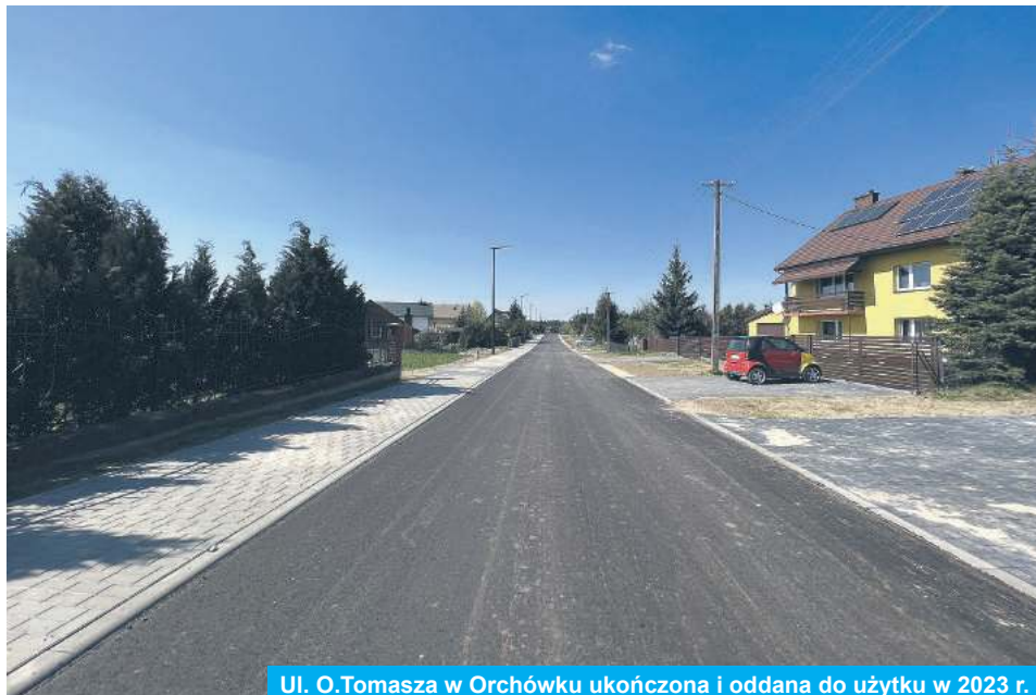
Ul. O.Tomasza w Orchówku ukończona i oddana do użytku w 2023 r.
