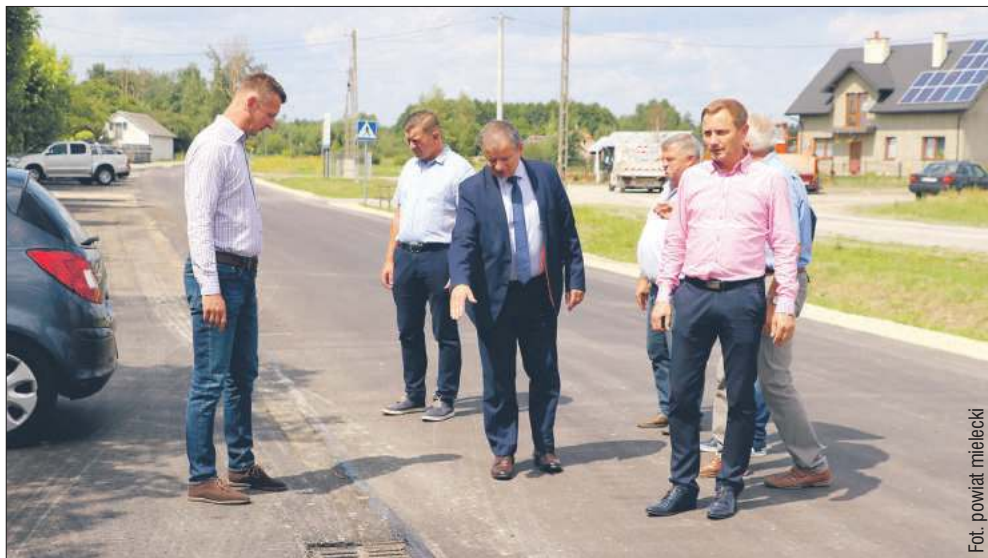
Po trudnym okresie pandemii na nowo ruszyły kolejne remonty i modernizacje drogowej infrastruktury.
