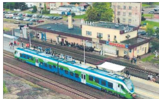
Budynek dworca po zmodernizowaniu odcinka linii 25 (Padew-Mielec-Dębica).
