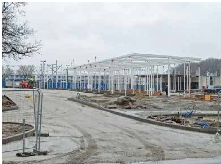
Teren budowy nowego dworca kolejowo-autobusowego
