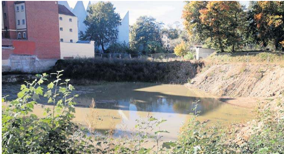
Na działce kupionej przez dewelopera był schron, który został wyburzony. W jego miejscu jest ogromna dziura
