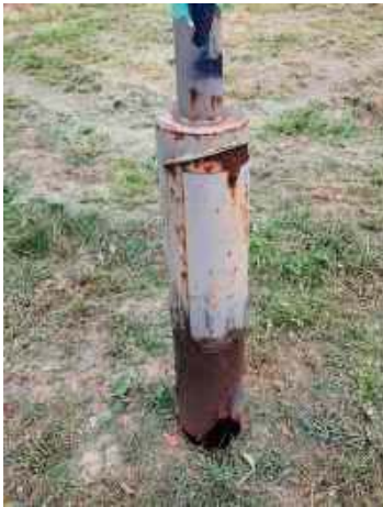
Latarnia u podstawy jest przeżarta przez rdzę niemal na wylot
