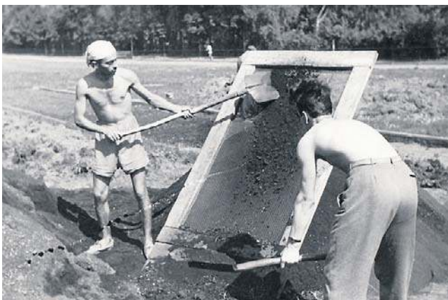
Sportowcy społecznie pomagają w budowie bieżni
