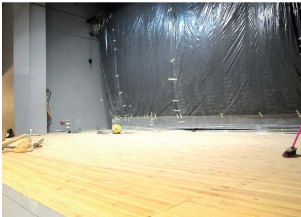
Modernizację przechodzi właśnie scena Nałęczowskiego Ośrodka Kultury. Podłoga została poddana cyklinowaniu, następnie zostanie zaolejowana i pomalowana na nowo
