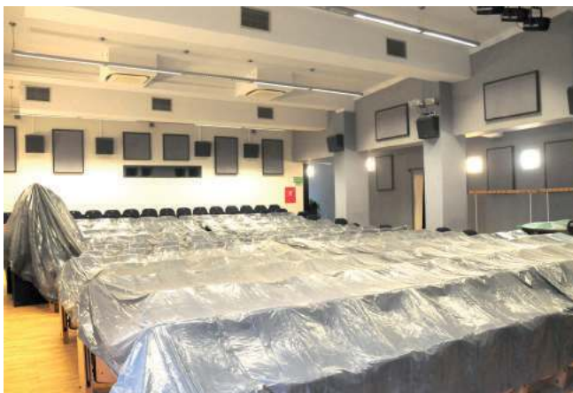
Jak zapowiada kierownictwo placówki, przymierza się również do odmalowania ścian sali widowiskowej. Na czas prac fotele na widowni zabezpieczono folią ochronną
