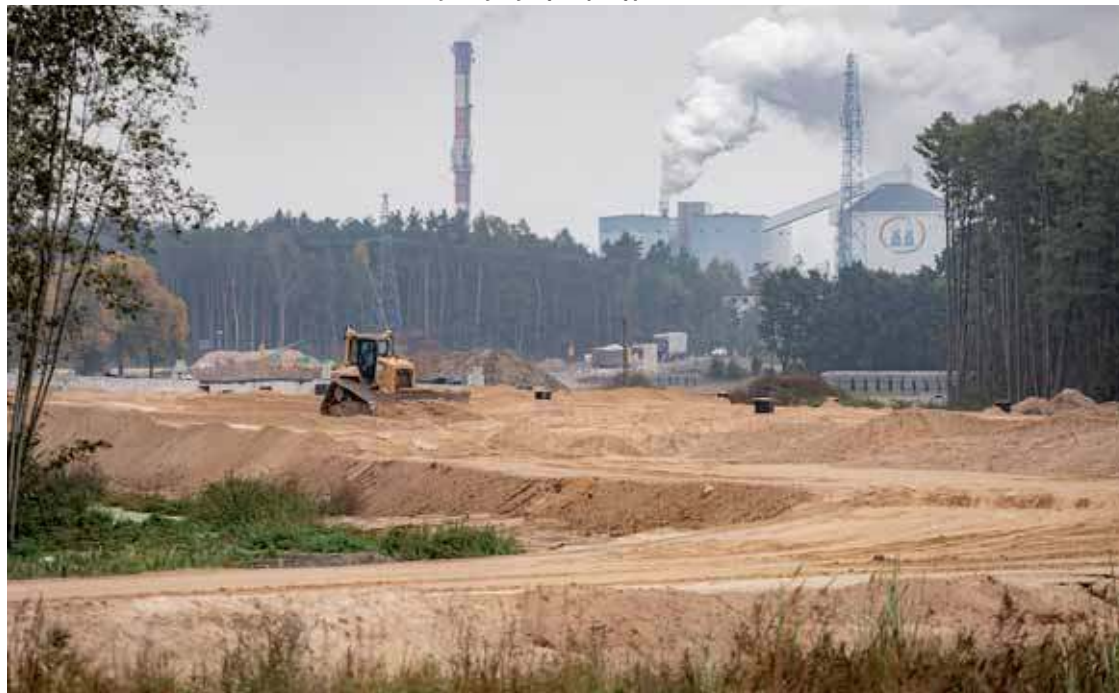
Na budowie zużywa się ogromne ilości materiałów budowlanych
