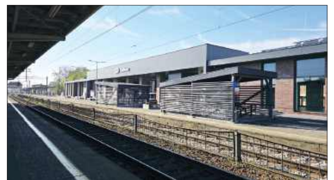
■ Widok dworca od strony torowiska
