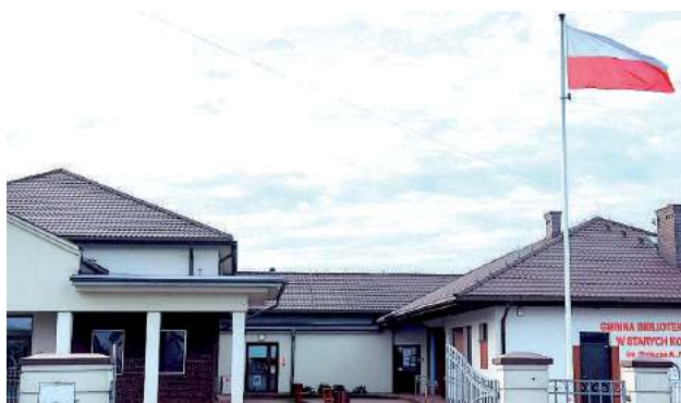
Budowa masztu została zrealizowana przy udziale środków z budżetu państwa. Całkowita wartość zadania wyniosła 8 tys. zł (fot. Gmina Stoczek Łukowski)
