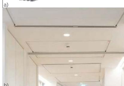
Fot. 4. Nawiewnik szczelinowy ze skrzynką rozprężną zapewniającą znaczne wyciszenie urządzenia
