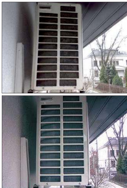
Fot. 5. Klimatyzator przed i po czyszczeniu Źródło: Wigmors
