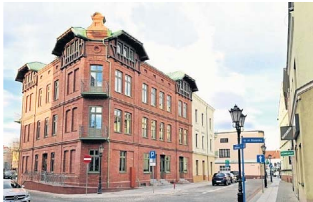
W ub. roku zakończyła się modernizacja kamienic przy ul. Mickiewicza 2 - 4 prowadzona przez OTBS
