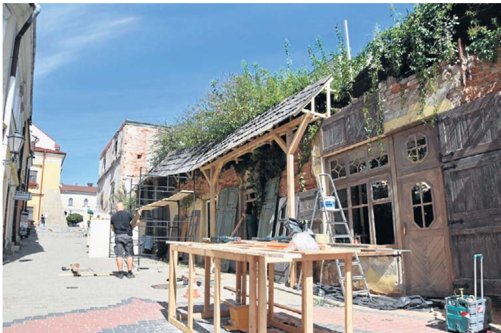
Na Wielkich Schodach trwa montaż scenografii do zdjęć nowej produkcji Netfliksa
