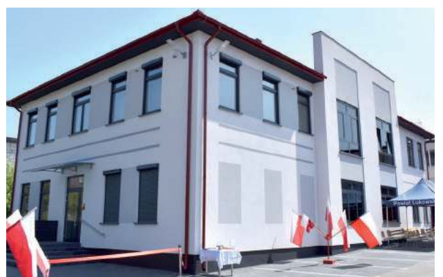
Powiatowe obchody Dnia Strażaka 2023 połączone były z poświęceniem i otwarciem nowego skrzydła budynku Komendy Powiatowej PSP w Łukowie
