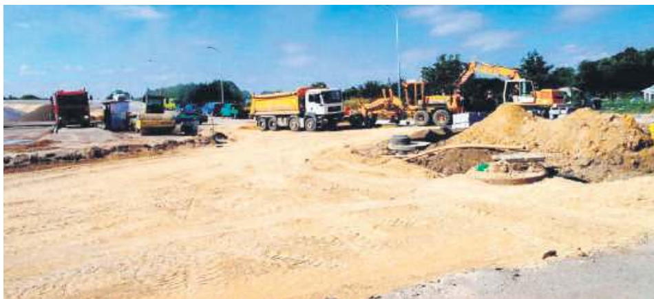
Prawdopodobnie w przyszłym roku rozpoczną się prace przy budowie północnej obwodnicy Hrubieszowa.
