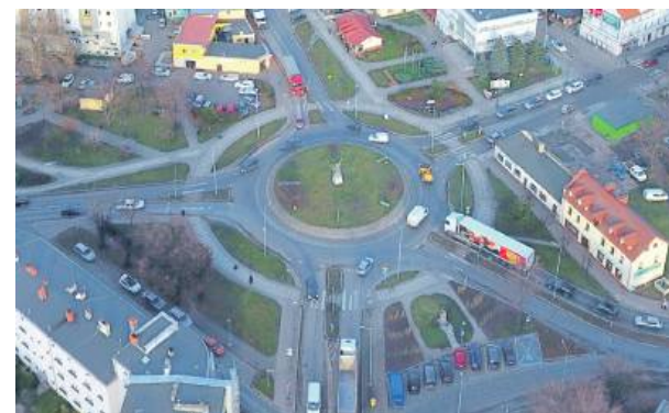
Przebudowa strzeleńskiego ronda będzie kosztowała około 4,7 mln zł
