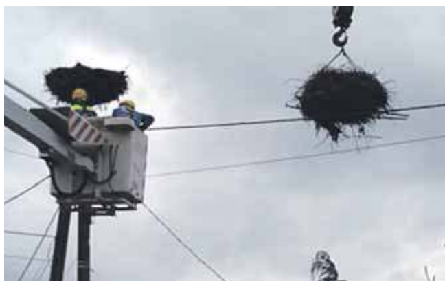
W Boruszowicach gniazdo przeniesiono na słup przy skrzyżowaniu ul. Łączności i ul. Szkolnej
