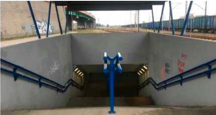
Dzisiaj przejście do tunelu pod ulicami Targową i Fabryczną, to dla osób niepełnosprawnych przeszkoda nie do pokonania
