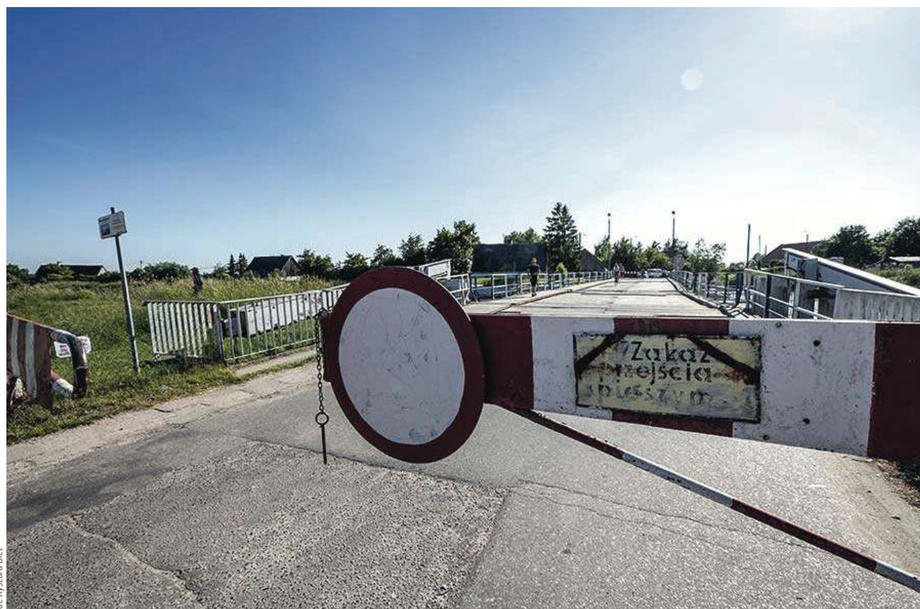
Most pontonowy w Nowakowie niedługo przejdzie do historii
