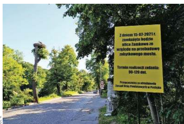
Na czas remontu ulica Zamkowa zostanie zamknięta
