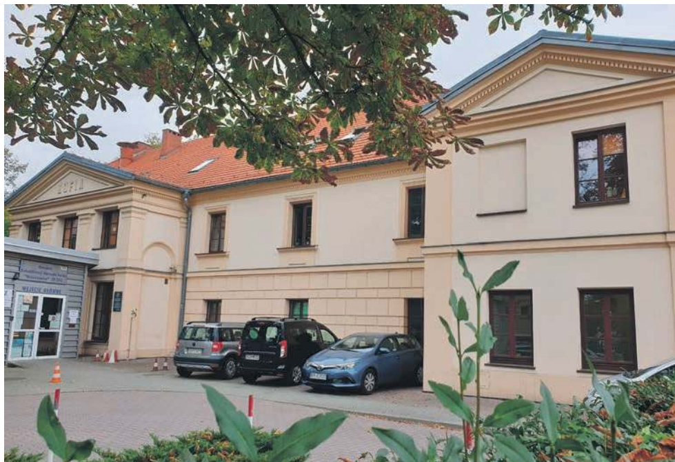
Ośrodek Rehabilitacji Narządu Ruchu od wielu lat czeka na modernizację
