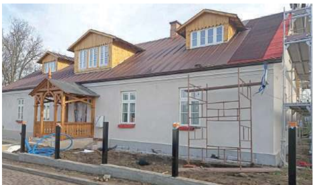
Przebudowa dawnej plebanii na Gminne Centrum Kultury trwała ponad rok. Otwarcie zaplanowano na 30 czerwca
