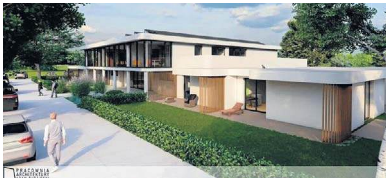
Tak ma wyglądać Ośrodek Wsparcia dla osób z autyzmem i innymi niepełnosprawnościami, którego budowa w ciągu najbliższych tygodni rozpocznie się w Toruniu
