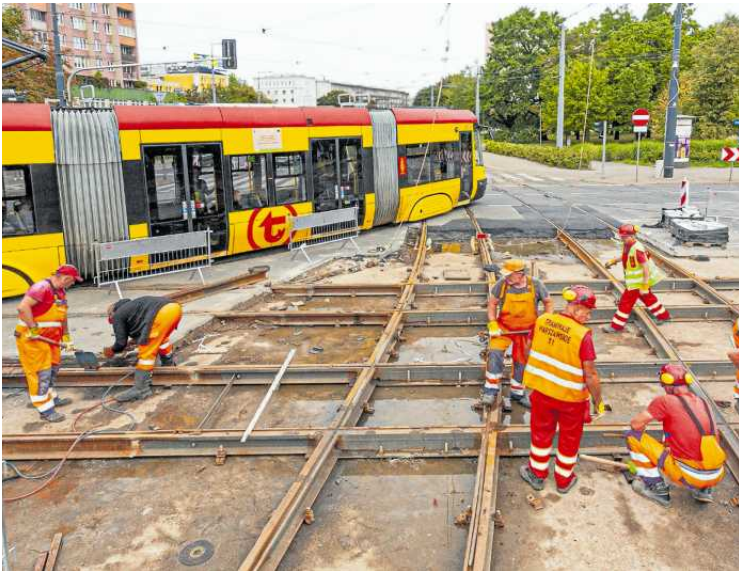
• Remont torów tramwajowych na Kercelaku u zbiegu ul. Okopowej z al. „Solidarności” zaplanowano między 29 lipca a 1 września
