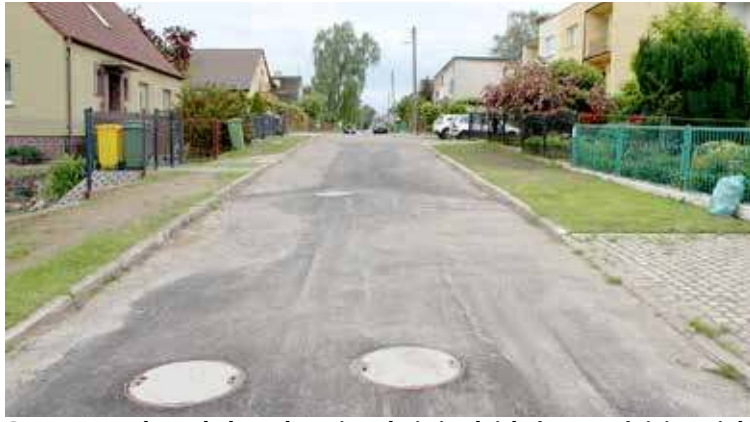
Prace prowadzone były pod powierzchnią jezdni, która wcześniej musiała być zerwana
