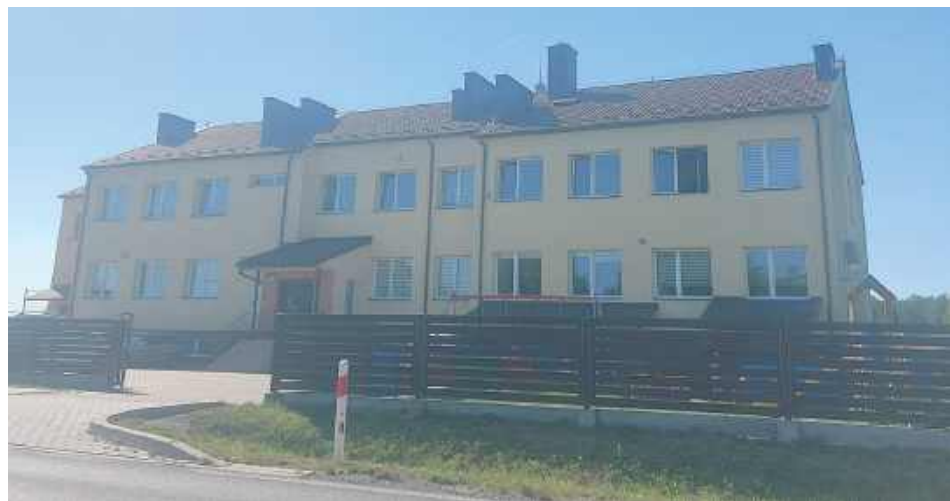
Budynek Szkoły Podstawowej w Korczowie
