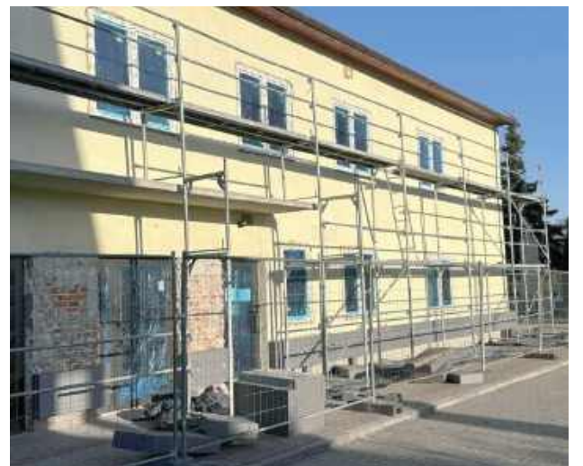
Najważniejszy budynek w gminie niemal z każdej strony jest osłonięty rusztowaniami. A pracuje normalnie przez cały czas
