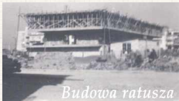
W 1963 r. Antoni Herman dostał propozycję opracowania projektu biłgorajskiego ratusza. Budowa trwała w latach 1963-1965, a budynek został oddany do użytku 8 stycznia 1966 r.
