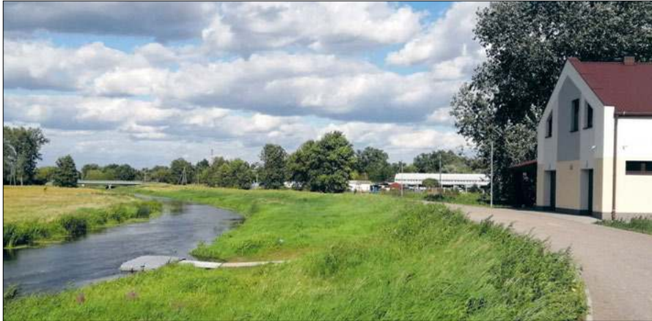
Pod koniec marca RZGW Wody Polskie w Lublinie ogłosiły przetarg na wykonanie dokumentacji projektowej na uszczelnienie wału przeciwpowodziowego
