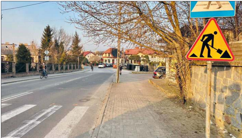
W ciągu ulicy Chomiczewskiego prace ruszyły tuż przed Wielkanocą
