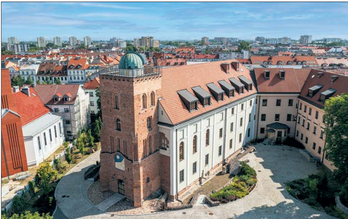
Najstarsze budynki Małachowianki zostały zrewitalizowane dzięki środkom unijnym. Teraz kolejna dotacja pozwoli na remont sali gimnastycznej i doposażenie placówki w nowoczesny sprzęt
