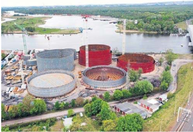
Tak wygląda baza paliw w Podjuchach, której budowa została zastopowana. Spór jednak nadal trwa
