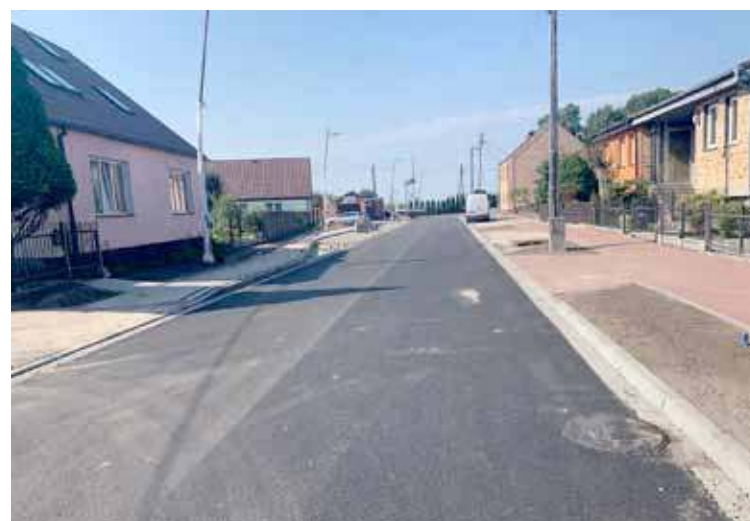
Na ulicy Lipowej w Lubczynie asfalt już wylany i trwają ostatnie prace wykończeniowe. Foto: Dariusz Jachno
