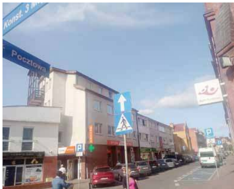
Na ul. Pocztovej przeprowadzony zostanie remont sieci wodociągowej, co spowoduje znaczne utrudnienia i brak wody w kranach
