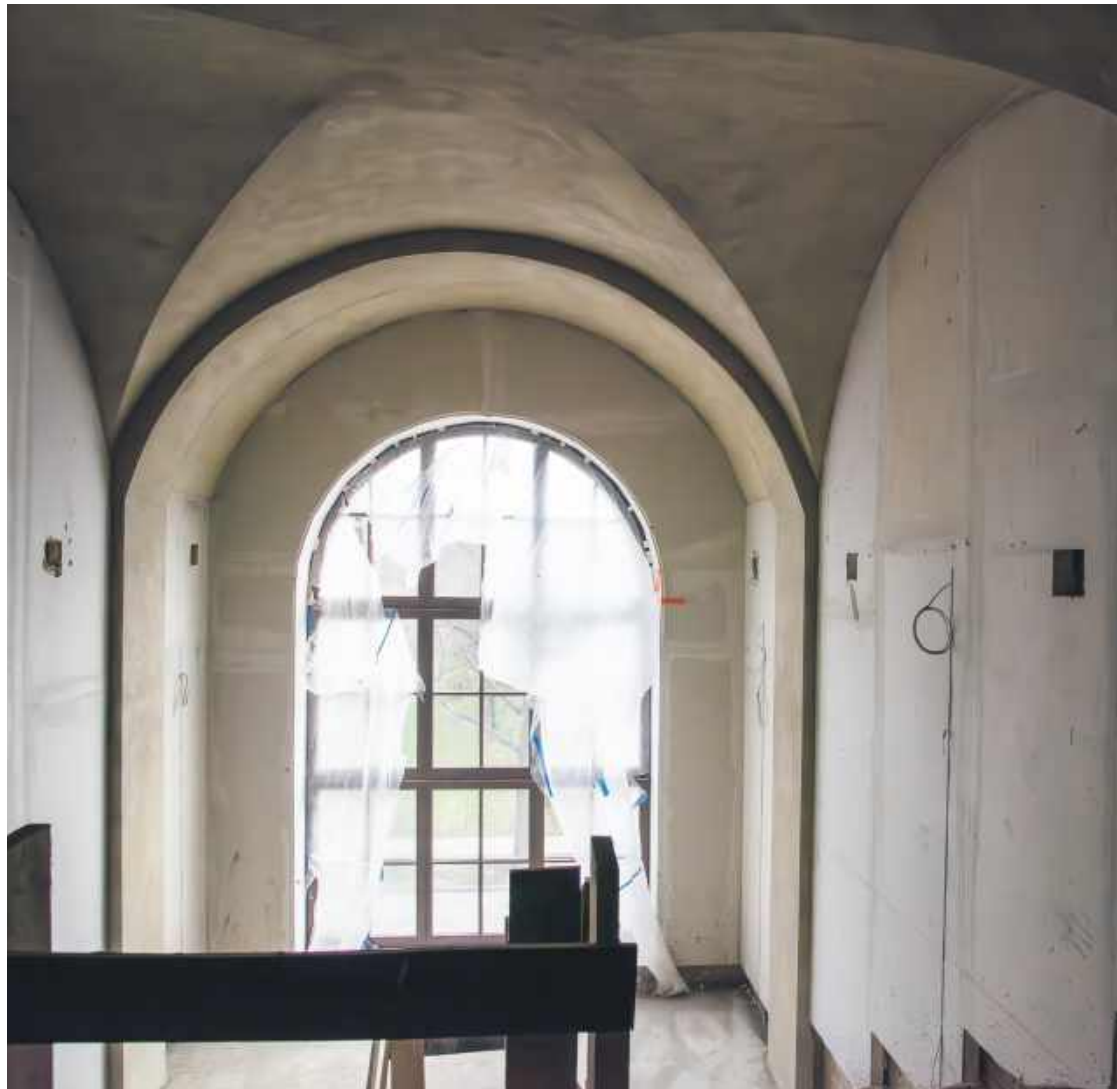
Duże, stylowe okna nadają wnętrzą ekskluzywnego charakteru
