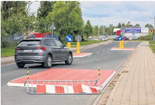
Wysieki mają, m.in., ograniczyć ruch samochodów ciężarowych na osiedlu Glinki-Rupienica
