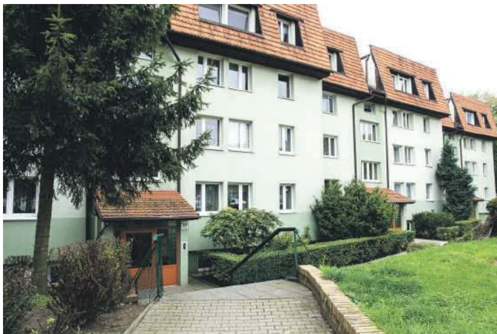
Sąsiedni blok doczekał się kompleksowych remontów, ale nie należy już do osiedla
