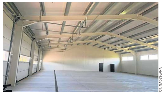
Gotowy magazyn ochrony ludności w Toporzysku. Teraz czas na drugi etap budowy kompleksu
