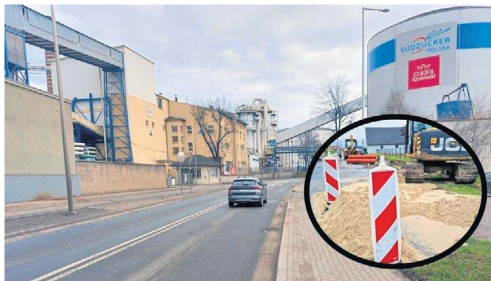
W ramach przebudowy powstanie 220 metrów chodnika.
