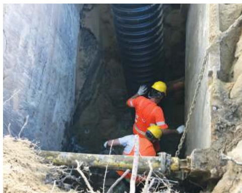
„Budowa sieci kanalizacyjnej ul. Wojska Polskiego dopływ z Białowiejskiej i 17 Sierpnia oraz przebudowa kanalizacji ogólnospławnej”
