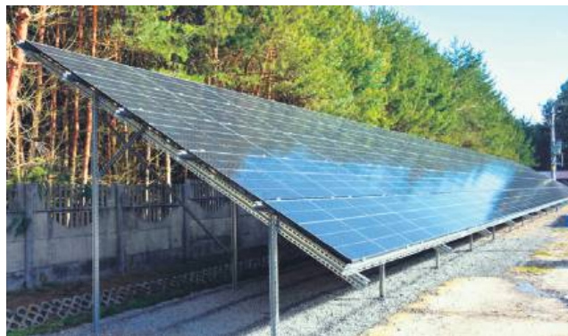
Zamontowanych zostanie 20 zestawów fotowoltaicznych.
