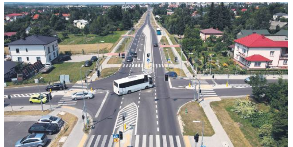
Prace na tym odcinku „siedemnastki” rozpoczęły się w czerwcu 2021 r.
