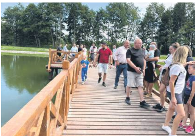
Na zbiorniku wybudowano kładkę.
