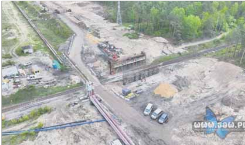
Jaworznicki Obszar Gospodarczy – budowa nowego układu drogowego
