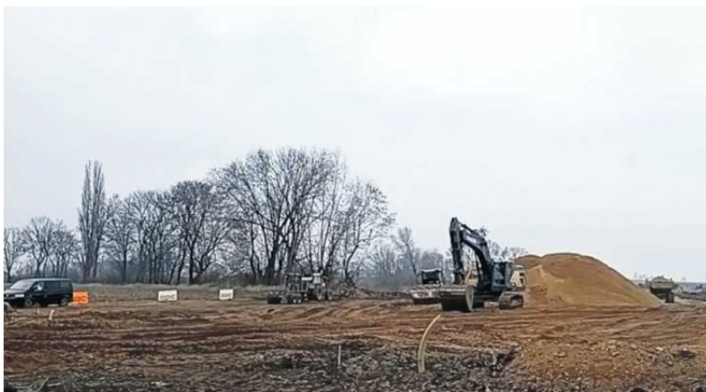
• Budowa odcinka S8 Jordanów Śląski – Łagiewniki Zachód FOT. M2STUDIO
