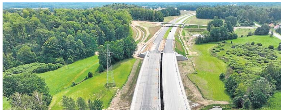
Budowa drogi ekspresowej S11 Bobolice – Szczecinek
